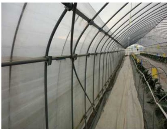
【 ハウス側面の両側の筋交い 】
