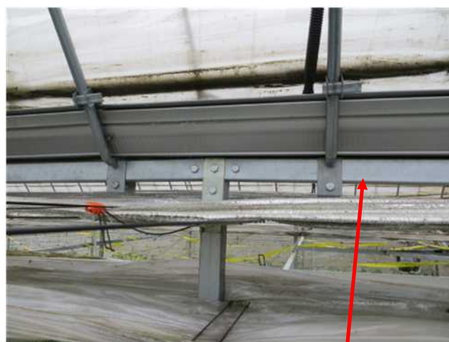
【 谷樋下を補強 (50 mmの角パイ) 】
