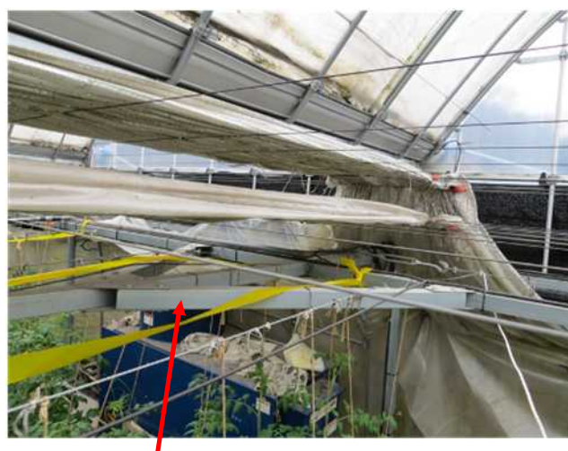
【 横ばりの補強 (50 mmの角パイ) 】
