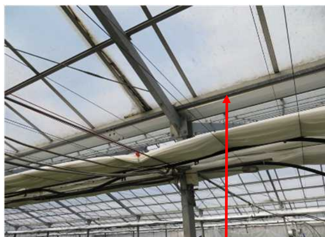
【 谷樋の両側をC鋼で補強 】
