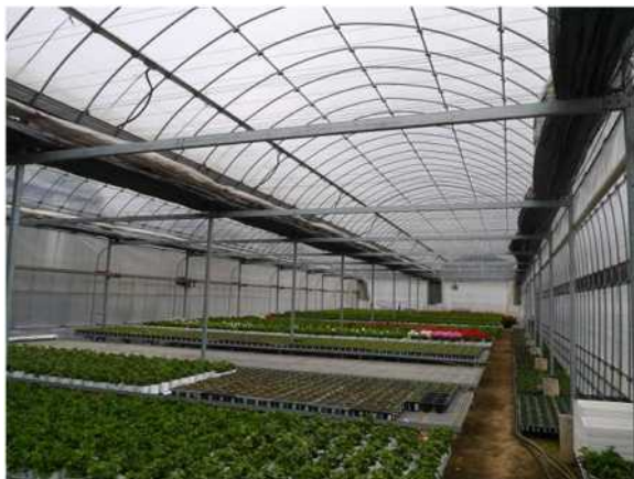
【 母屋パイプによる小屋高部の補強 】
