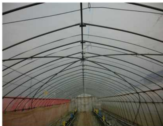
【 ハウス中央部の筋交い 】
