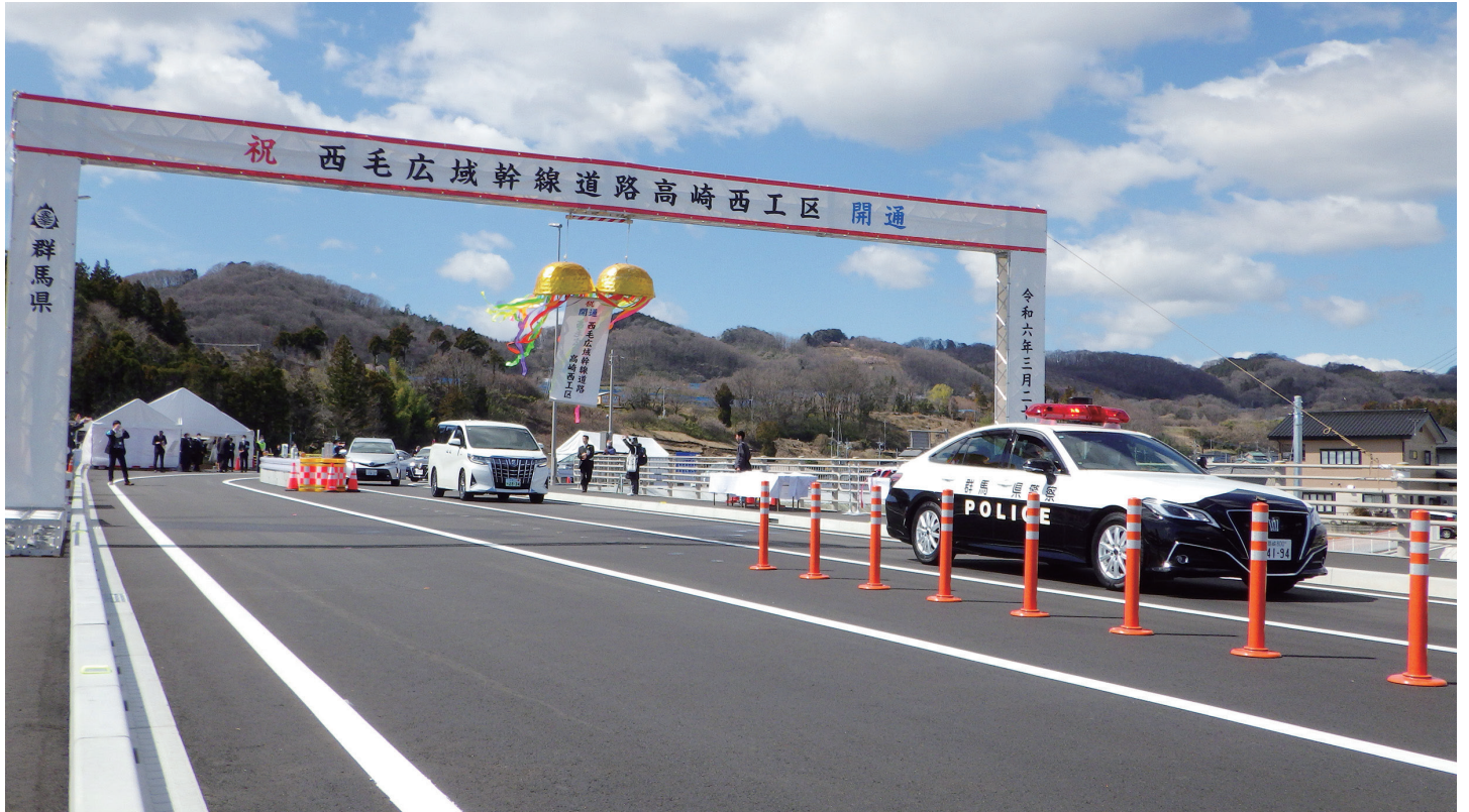
西毛広域幹線道路(高崎西工区)開通式の通り初め
