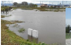
整備済み調節池の 雨水貯留時の状況
