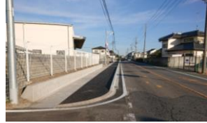
歩道整備状況
