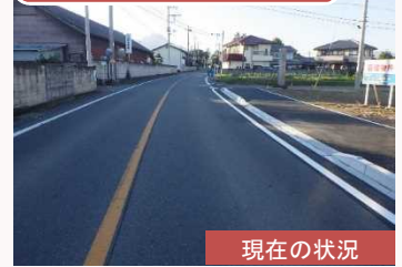
県道前橋伊香保線 大久保工区
