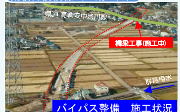
バイパス整備 施工状況
