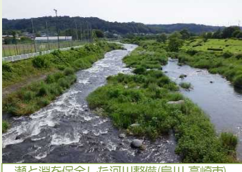
瀬と淵を保全した河川整備(烏川 高崎市)
