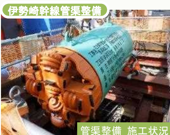
管渠整備 施工状況
