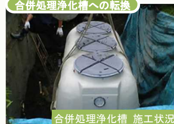
合併処理浄化槽 施工状況
