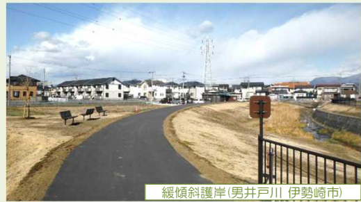
緩傾斜護岸(男井戸川 伊勢崎市)
