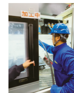
高圧洗浄作業
