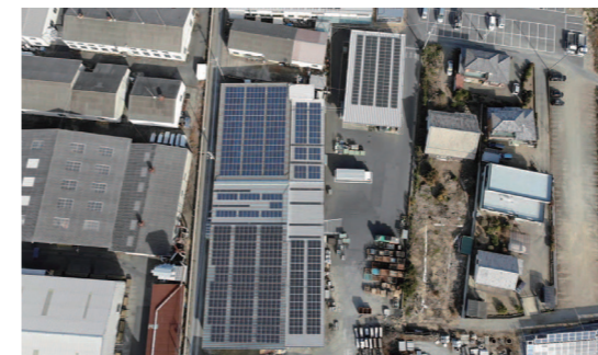
本社・第一工場
