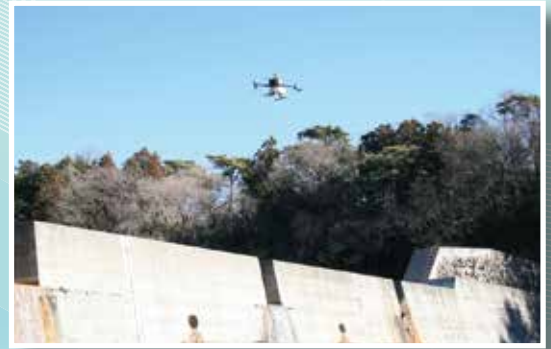
（前橋市の粕川105砂防堰堤のドローン点検）
