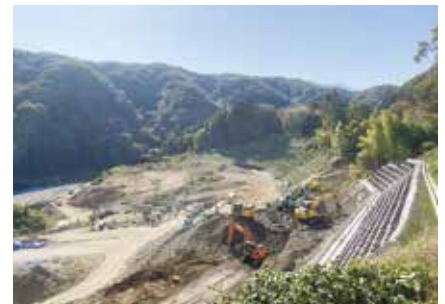
【災害復旧工事現場】
