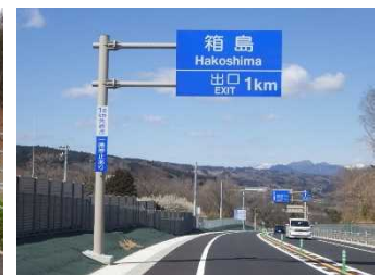
■ 案内標識の施工事例
