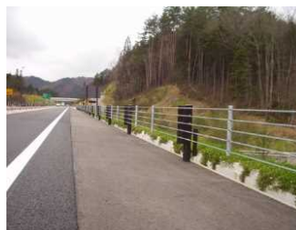
■ ガードケーブルの施工事例
