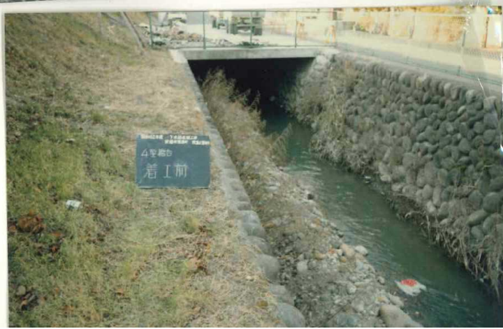
4型橋台工 着工前
