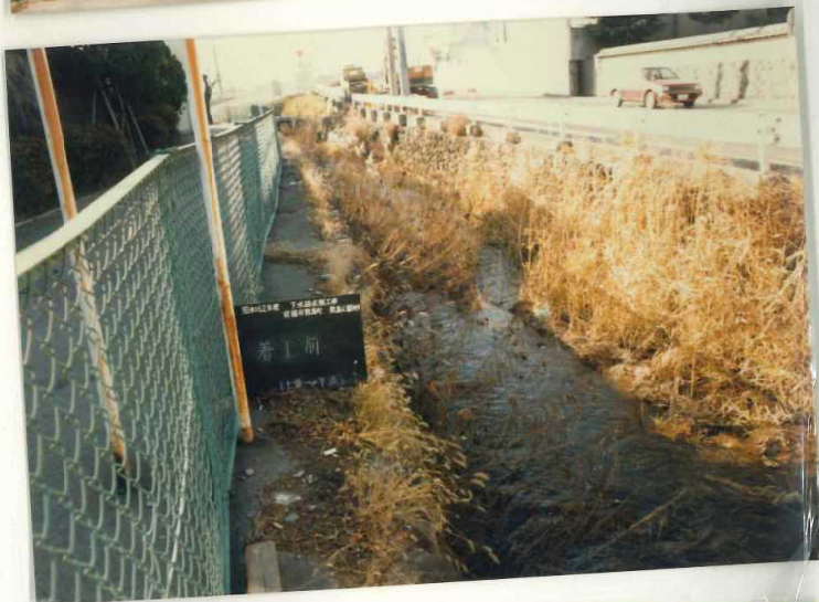
着工前 上流→下流
