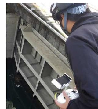
〔水中ドローンによる点検 (試行)〕
