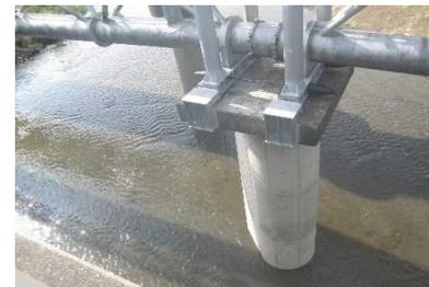
〔東毛工業用水道水管橋耐震化〕
