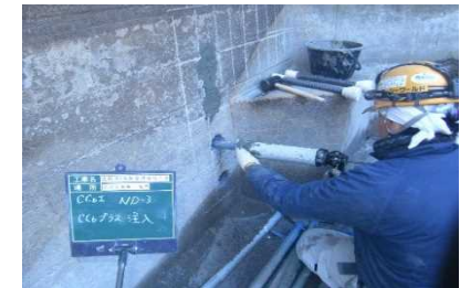
〔渋川工業用水道沈澱池補強〕
