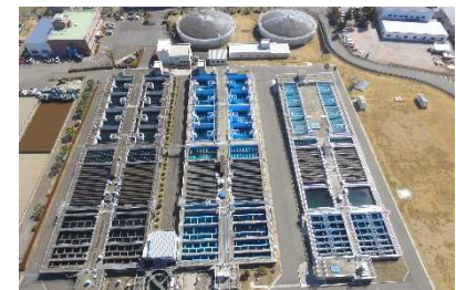
〔県央第一水道浄水場〕
