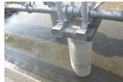
〔東毛工業用水道水管橋耐震化〕
