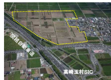
〔高崎玉村スマートI C北地区工業団地〕
