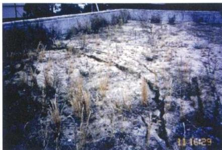
宅地地盤に円弧状にひび割れが生じています。擁壁が転倒する可能性があるため、擁壁の状態を確認する必要があります。
