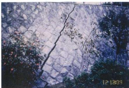
斜めのクラック（≒ひび割れ）が、縦横や両方の要因により、ブロックの目に沿って生じています。
