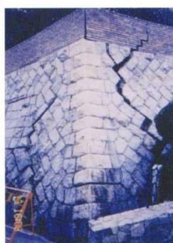
隅部は、お互いに擁壁が交わる箇所での引っ張りあいにより、被害が生じることが多く、鉄筋等により適切な補強が必要です。
