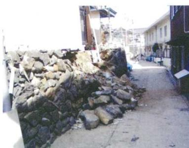
空石積擁壁直上に建物がある場合の例です。建物に被害を受けなくても、擁壁の破壊により危険な状態になることがあります。
