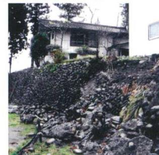
強度の不足と水抜き穴の未設置のため、大規模に崩壊しています。
