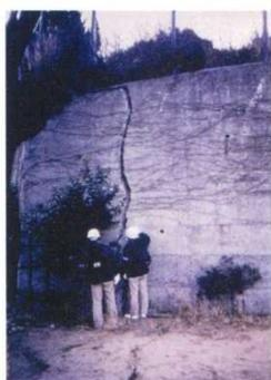
宅地地盤性能や擁壁断面などに問題がある箇所が、大きな地震力を受けたため、クラック（≒ひび割れ）が生じたと考えられます。
