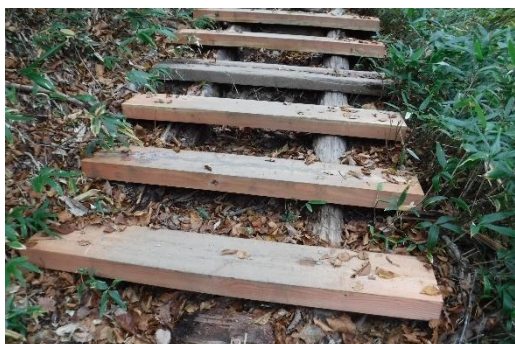
階段の踏み板更新
