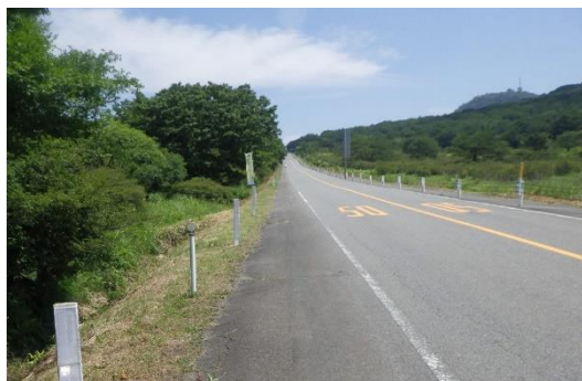
道路の除草状況（渋川松井田線）
