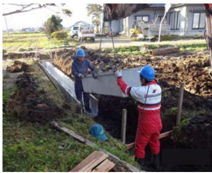
用水路更新（山形県）
