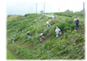
法面の共同草刈り作業
