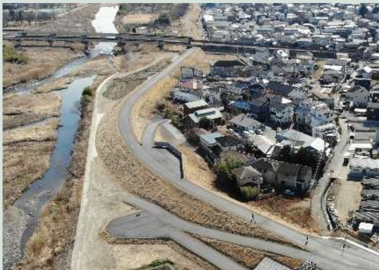
烏川堤防整備
