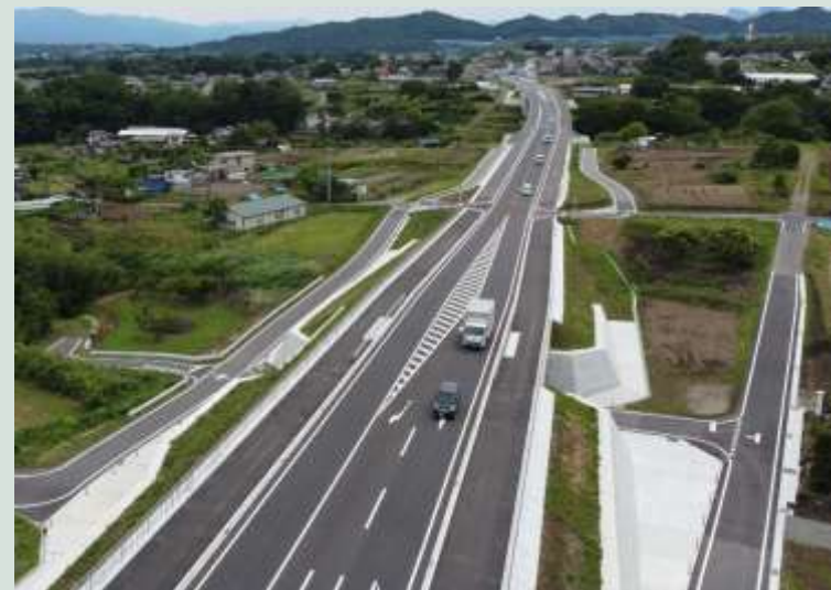
西毛広域幹線道路(高崎西工区)の一部区間が開通
