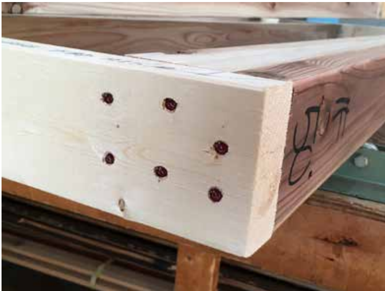
木口打ちされたスギスタッド
