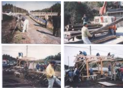
わくわく運動遊園建設
