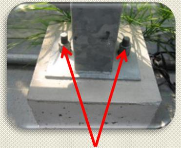
沓石と柱（ダブルナットで固定）
