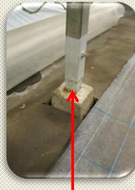
沓石と柱に錆止めと腐食防止剤の塗布
