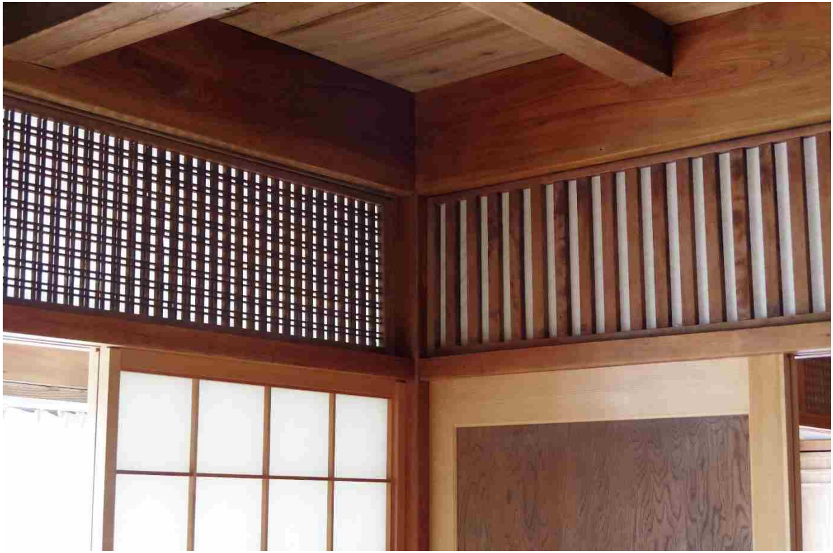
6 太い梁と繊細な欄間
