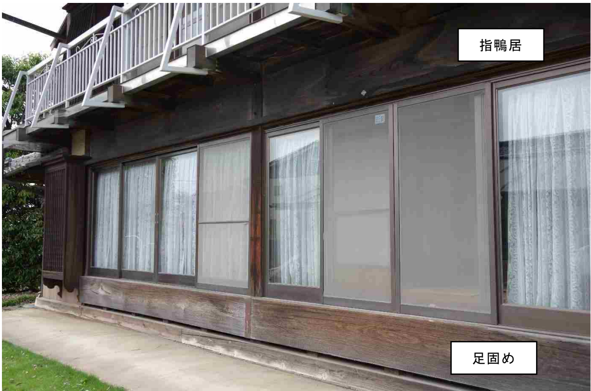
3 太い材を使用した指鴨居と足固め
