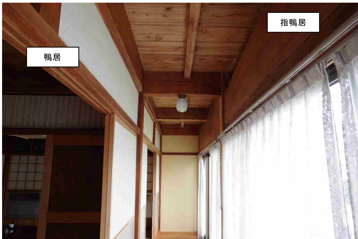
4 1階正面縁側（右側（外側）は太い指鴨居、左側（室内側）の鴨居は繊細な造り）
