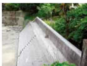
氾濫した河川の堤防かさ上げ
