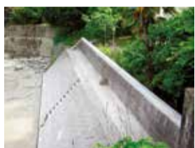
氾濫した河川の堤防かさ上げ
