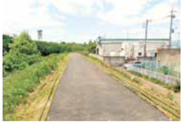
井野川の堤防天端の舗装状況
