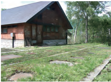
▲ 公衆トイレ裏の合併処理浄化槽
