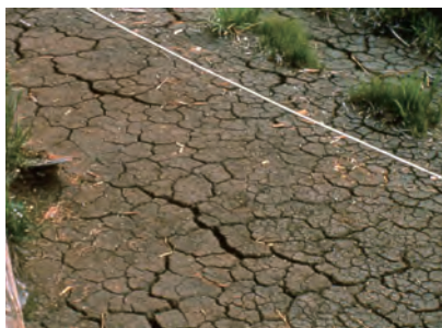
▲ひび割れた泥炭
