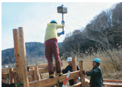
▲木道工事は手作業で行う
