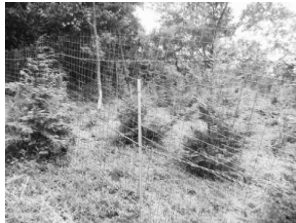
図-22 単管パイプでたわみを補強
