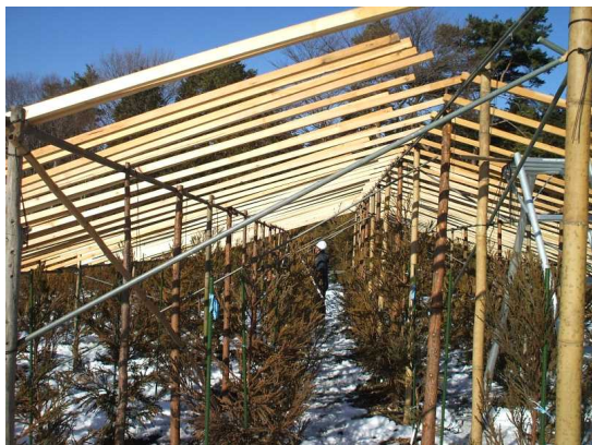
図-3 簡易防除施設施行状況
