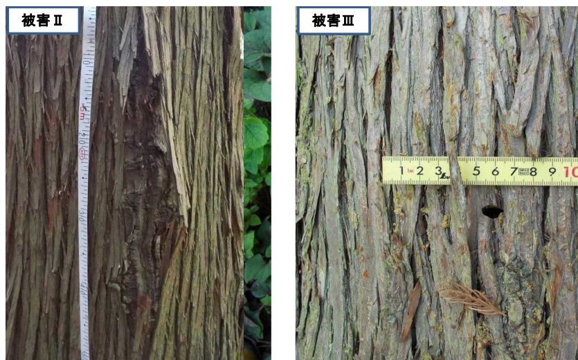
図－2 被害調査における区分（2）
