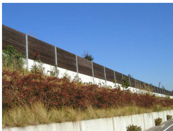
図-1 遮音壁の様子
