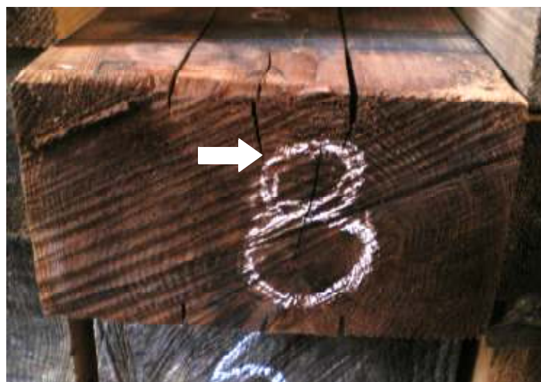
図- 17 スリット部外に発生した材面割れ
