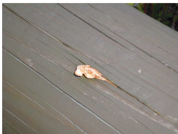
図－10 4年経過時の劣化状況 (21世紀の森、被害度1)
