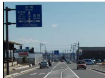
1期工区開通後の道路状況
