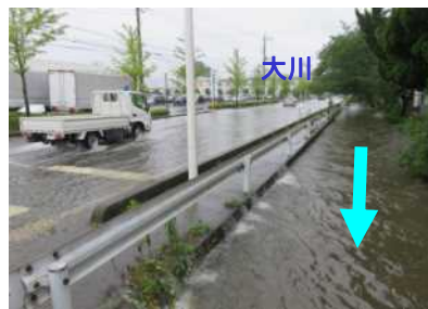
H27.7氾濫状況(太田市新田木崎町)
