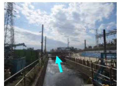
東武鉄道橋の施工状況(H27.10)
