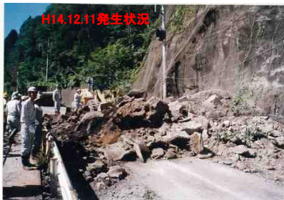
国道353号の崩落事故発生状況
