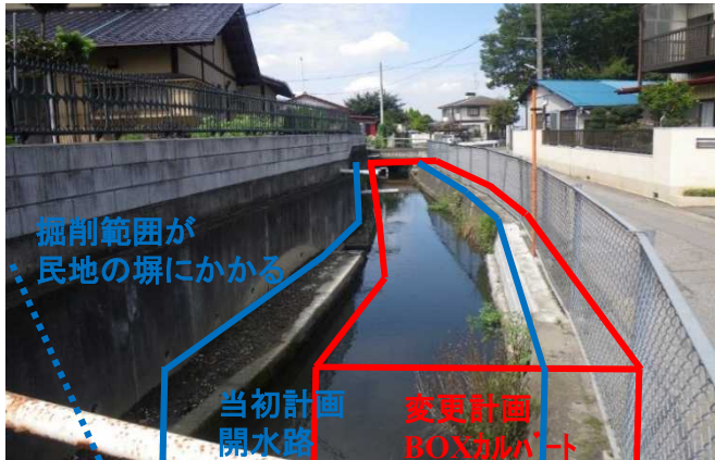
集落内を通る水路の状況
