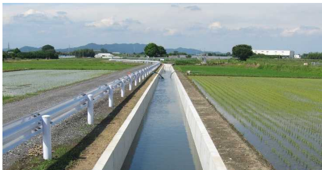
頭沼用水路(整備後)
