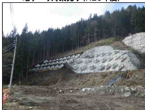
地すべり対策完了(H25年度)
