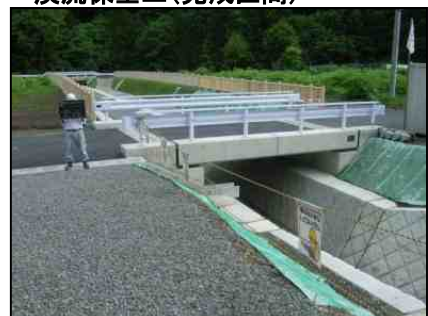
溪流保全工(完成区間)
