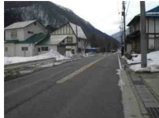
保全対象((主)水上片品線、人家)
