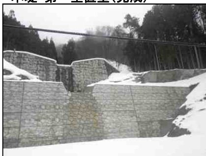
本堤・第一垂直壁(完成)
