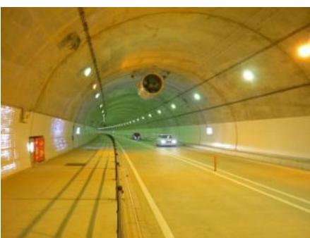
茂四郎トンネル H22供用開始
