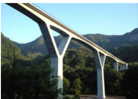
丸岩大橋(湖面3号橋) H21年度架設
