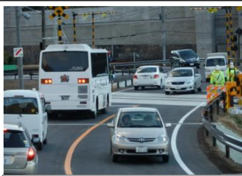
松谷地区のJR吾妻線との暫定交差状況
