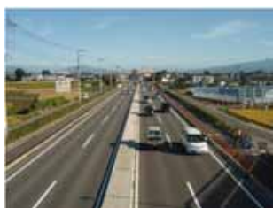
バイパス供用区間
