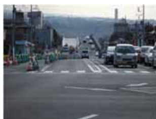
上信自動車道建設中
