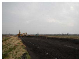
国道122号八重笠道路工事状況 (平成25年度末供用予定)
