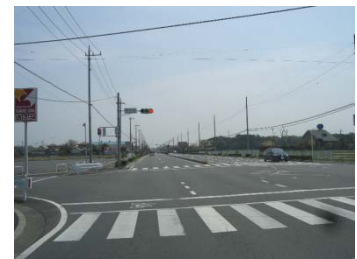
改良後現道拡幅区間状況
