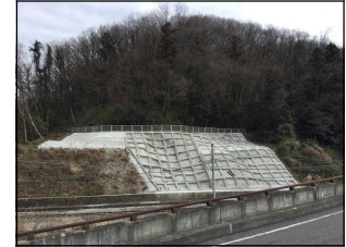
【切土による土砂災害対策】
