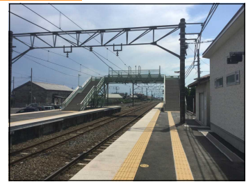
【ホームの点状ブロック整備】
