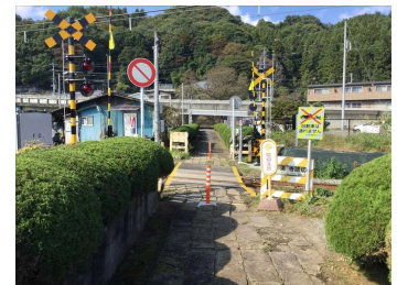
【踏切遮断機の整備】
