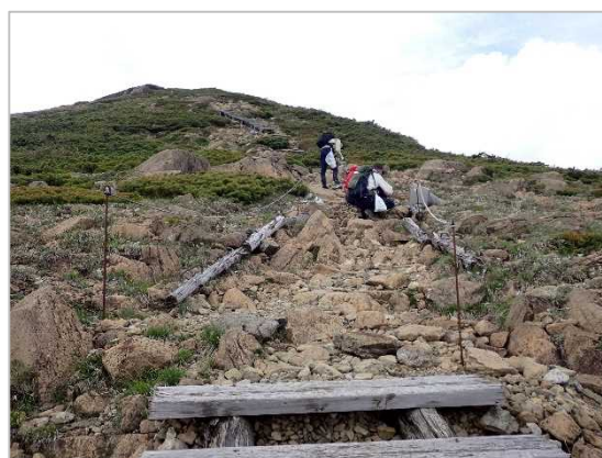
登山道外への踏み出し防止柵の設置
