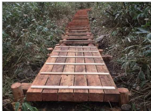
県管理木道修繕 (至仏山東面登山道)
