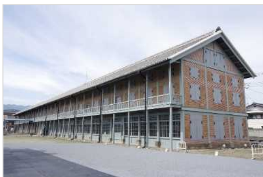
富岡製糸場西置繭所（画像提供：富岡市）
