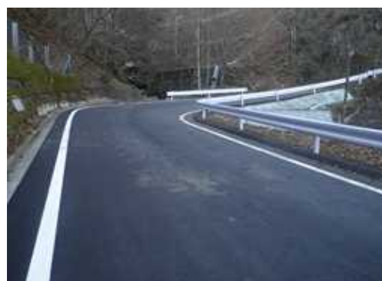
復旧工事後の状況
