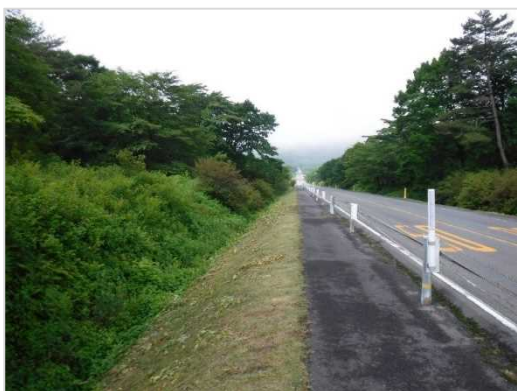
道路の除草状況（渋川松井田線）
