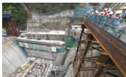
建設中の八ツ場発電所
