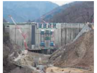
建設が進むハッ場ダム(31年2月)
