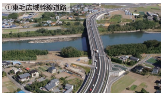
①東毛広域幹線道路 この道路の完成で、高崎駅と関越自動車道、上武道路、東北自動車道がつながりました。
