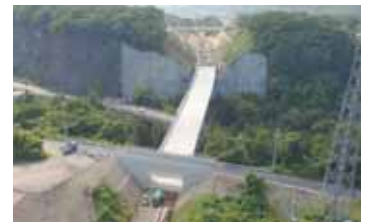
建設中の上信自動車道
