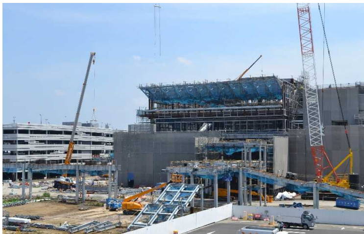
△① 会議・展示施設北側の2階エントランスまわりの工事の様子
