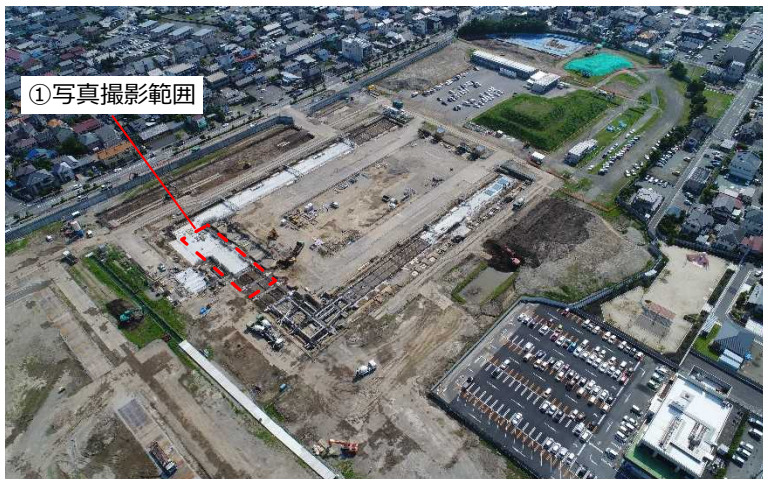
△ ② 敷地上空からの工事の様子
