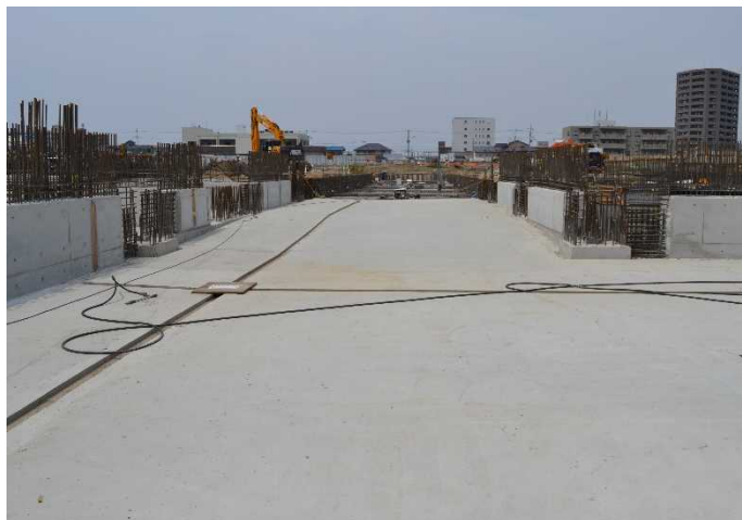
△ ① 地下(設備トレンチ)の床が完了した部分
