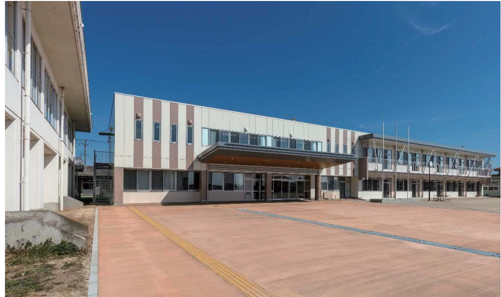
館林特別支援学校の教室不足や老朽化に対応するため、改築工事を実施しました。
