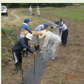
(侵入防止柵の設置)
